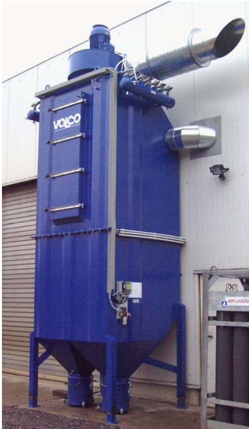
FPLAX-70 mit 18 kW-Ventilator, 8000 m³/h, Plasmaschneiden
